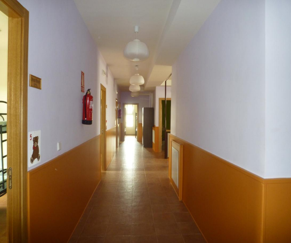
Pasillo primera planta
